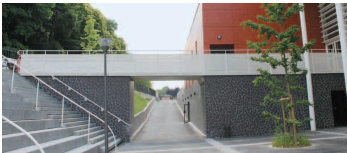
Progetto: Arch. M. Hesters (F) - Maglia: Academy - DL 115 x DC 40 (48) - av 20 x sp 1,5 mm Acciaio al carbonio zincato verniciato
