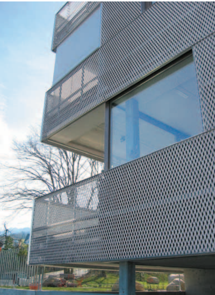
Progetto: Halter Generalunternehmung AG (CH) - Maglia: Ambasciata - DL 110 x DC 40 (52) - av 24 x sp 2 mm Alluminio pallinato - Foto: Metallpfister
