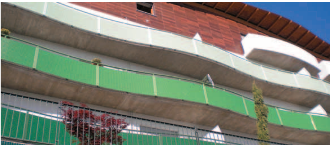
Progetto: Ing. Giuditta Pezzotta - Maglia: Idea - DL 76 x DC 31 (24) - av 11 x sp 1,5 mm Acciaio al carbonio zincato verniciato
