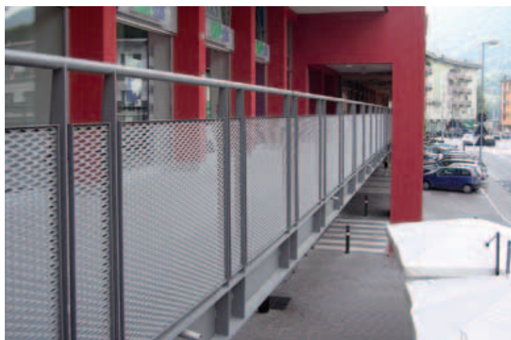
Progetto: Metalltech - Maglia: Fils 5 - DL 62,5 x DC 20 (20) - av 7,5 x sp 1,5 mm Acciaio al carbonio zincato verniciato
